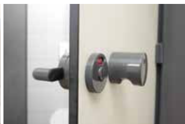
Vaste deurknop en slot met vrij - bezet indicatie uit nylon
