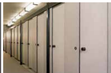
Bij vrijstaande opstellingen worden om de 4 cabines steunpalen voorzien
